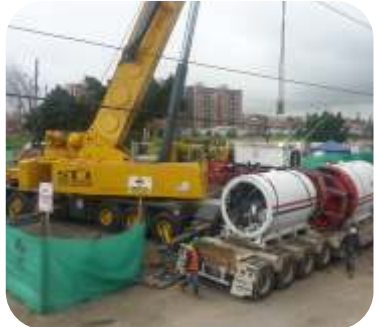
Cruce Avenida Ciudad de Cali Calle 10 – Bogotá
