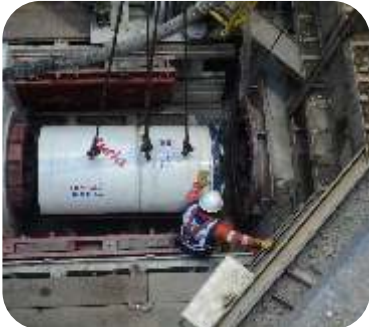
Deprimido Calle 94 – Bogotá
