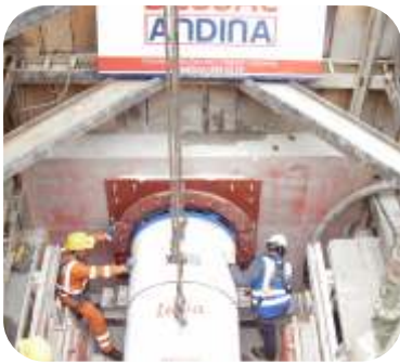
Deprimido Calle 94 – Bogotá
