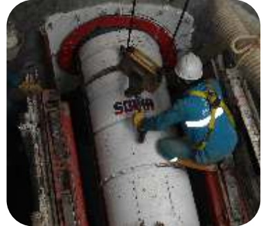
Alcantarillado Fontibón – Bogotá
